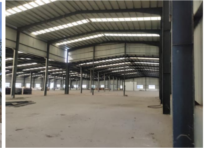
租赁厂房内部
