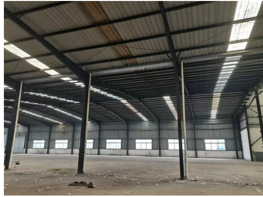
厂区北侧（闲置厂房）
