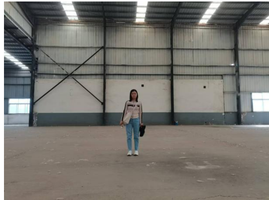
工程师看现场照片
