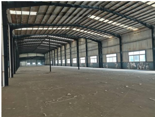
厂房内部现状
