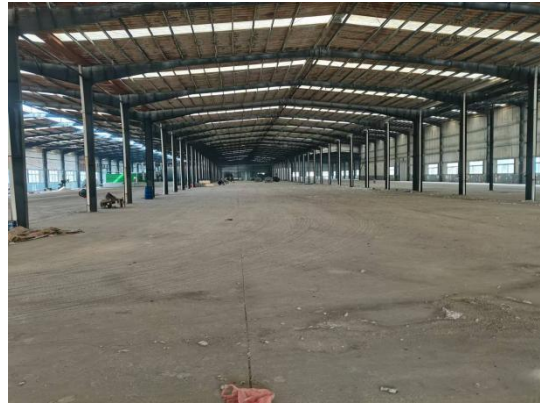
厂区西侧（闲置厂房）
